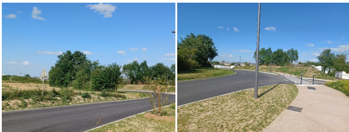
Le prolongement de la rue Ampère au droit du site d'implantation de Schneider Electric (photo mai 2026 – Urbicand)
