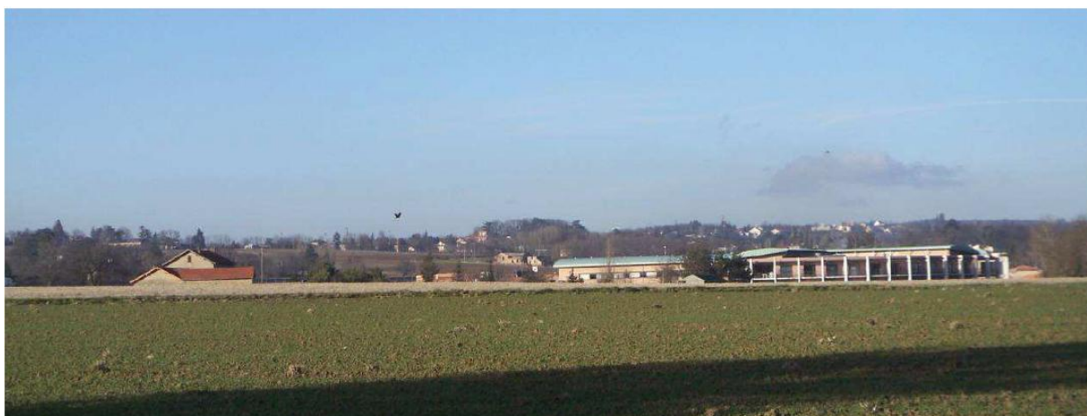
Secteur Les luminaires (AUX1)
